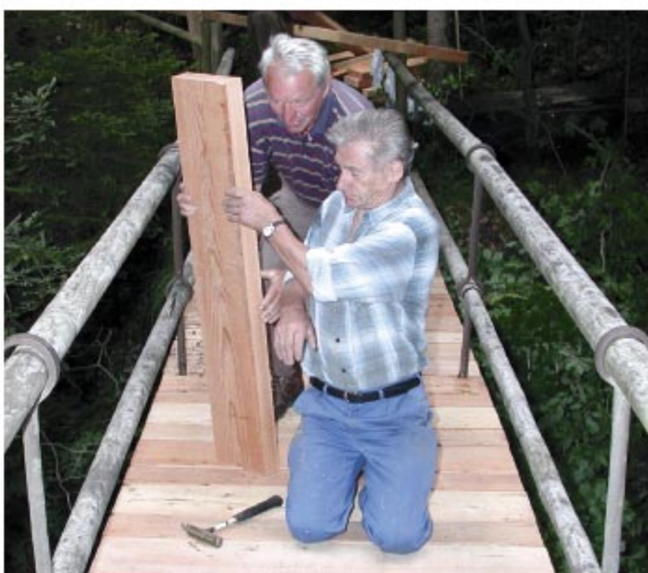
Errichtung von Brücken und Treppen
