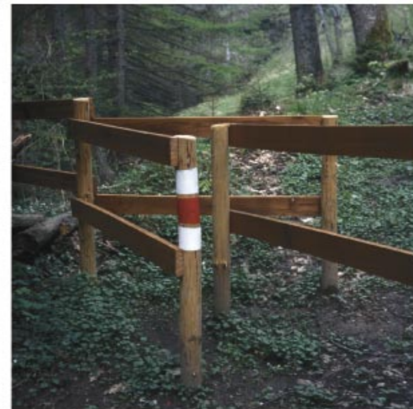
Errichtung von Weidedurchgängen
