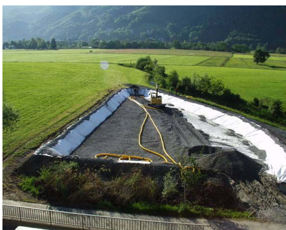
Abb. 6: Legung der Dränagen.
