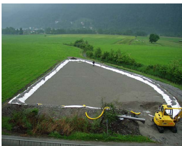
Abb. 8: Anlage gefüllt mit Sand.
