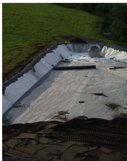
Abb. 7: Sandschüttung in der Anlage.
