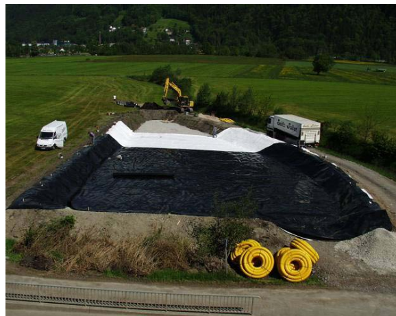
Abb. 5: Legung der Dichtungsbahn.
