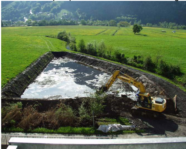
Abb. 3: Erster Bauabschnitt der Anlage.
