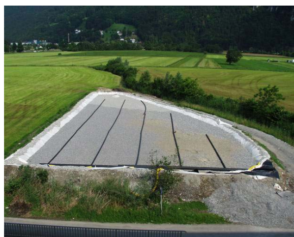
Abb. 9: Ausbringungsleitungen.
