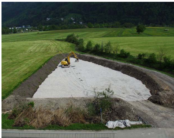
Abb. 4: Grobkiesgrundlage der Anlage.
