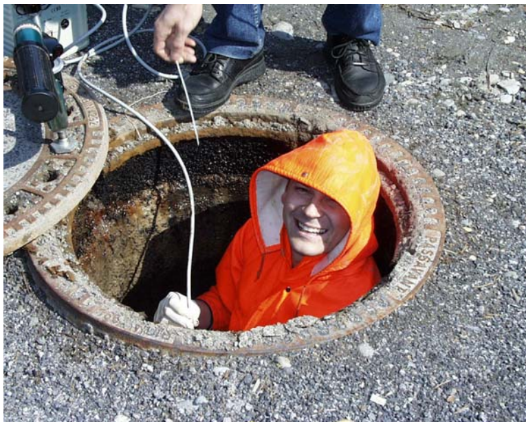
Abbildung 4: Einbau von Messeinrichtungen in den Kanalschacht
