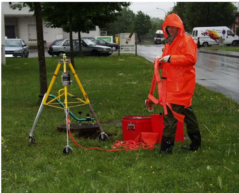
Abbildung 8: Sicherung durch den Einsatz eines Dreibeins
