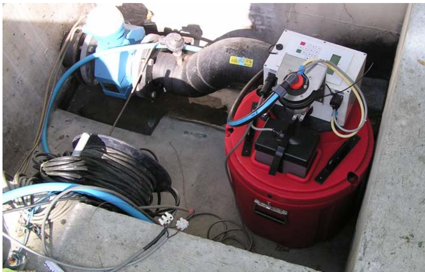
Abbildung 7: Einsatz eines mobilen Probenehmers bei einem Abwasserrohr
