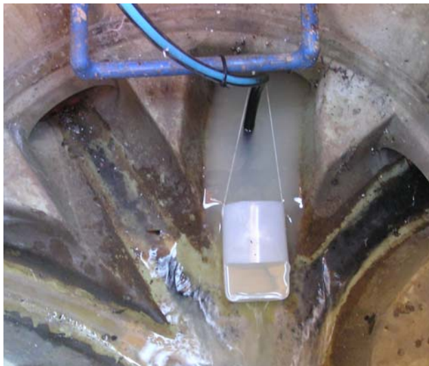
Abbildung 5: Sicherung eines ausreichenden Wasserstands im Bereich der Ansaugstelle mit einem aufgeschnittenen und durchbohrten Kunststoffbecher
