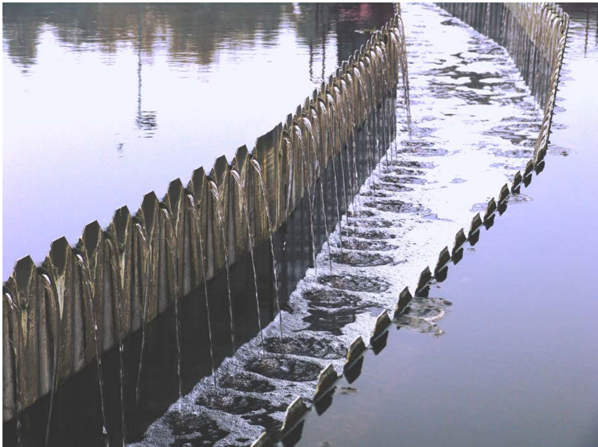
Abbildung 8: Nachklärbeckenablauf der ARA Dornbirn
