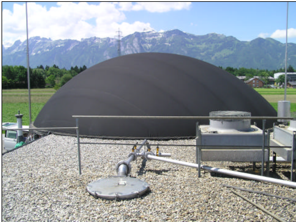
Abbildung 1: Foliengasspeicher einer Biogasanlage
