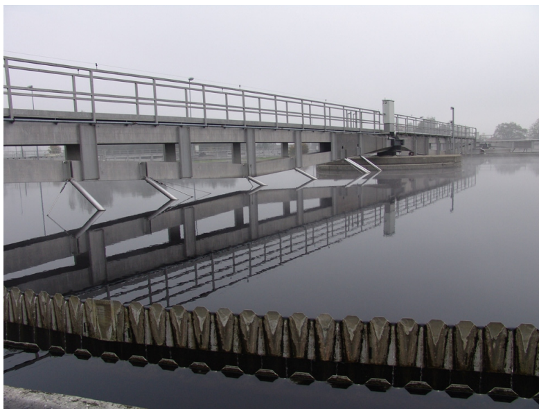
Abbildung 1: Nachklärbecken der ARA Dornbirn
