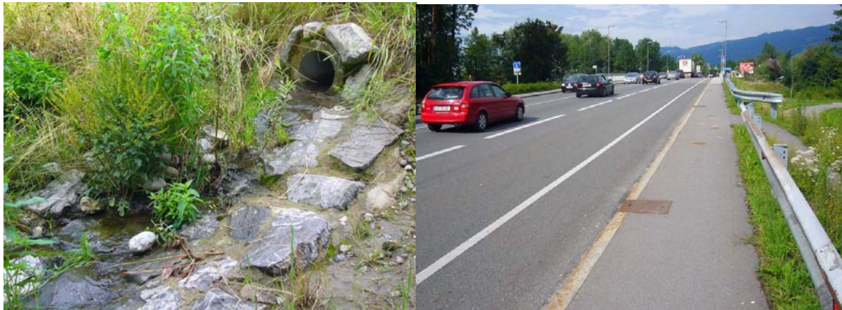
Abbildung 9: Ablauf und entwässerter Straßenabschnitt im Juni 2007
