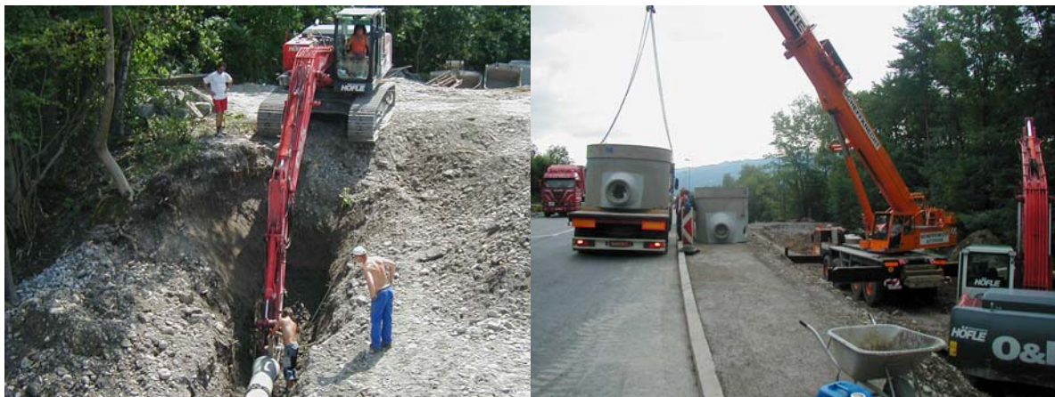
Abbildung 8: Zulauf und Vorreinigungsanlagen im Bauzustand Juli 2003
