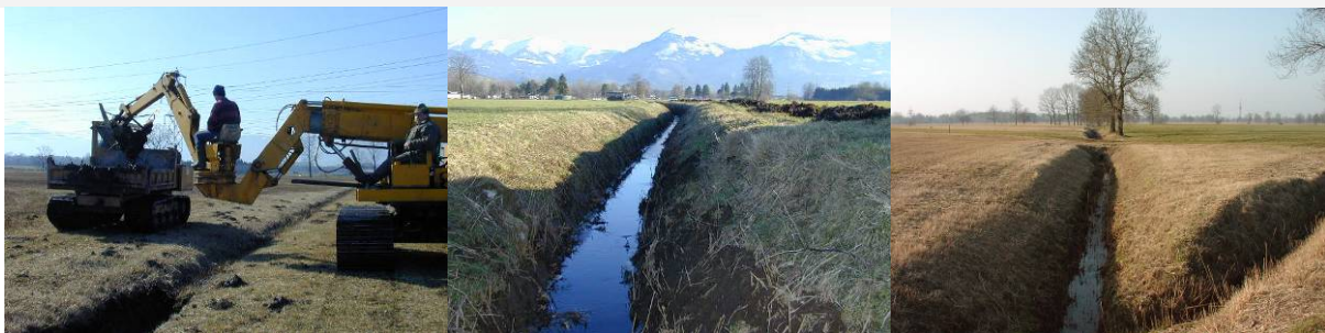
Abbildung Links: Spezialbagger; Mitte: Räumgut oberhalb Böschung; Rechts: Geräumter Riedgraben
