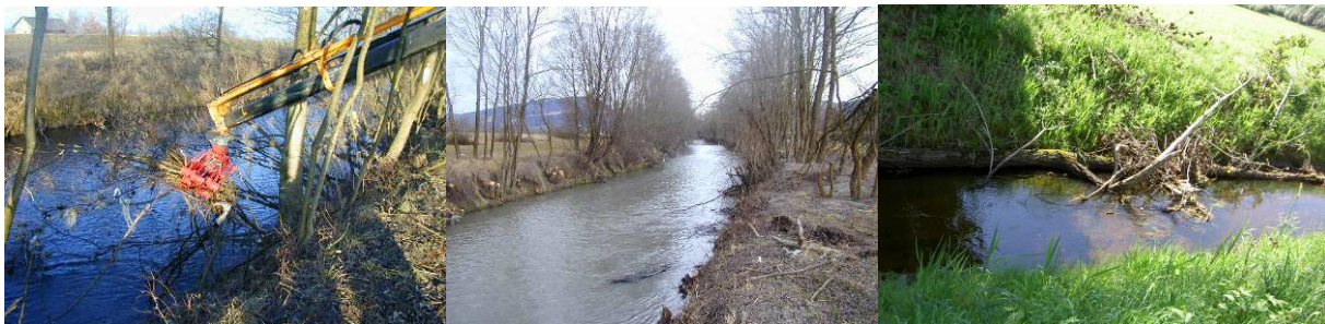
Abbildung Links: Maschinelle Entfernung eines einzelnen Baums; Rechts: Totholz im Gewässer belassen
