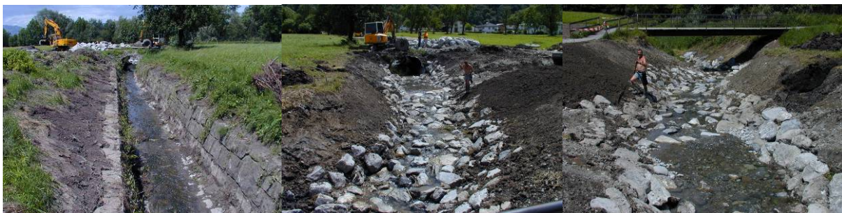
Abbildung Links: gemauerter Sohle; Mitte und Rechts: offene Sohle nach Sanierung mittels rau verlegter Wasserbausteine
