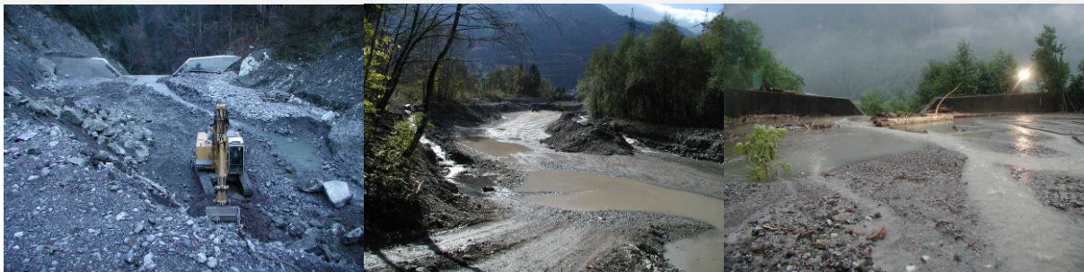
Abbildung: Geschieberäumung mit Umleitung des Gewässers
