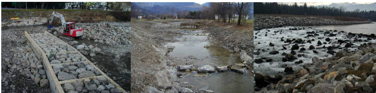
Abbildung Links: Sohlschwelle - Holz und Steine; Mitte: einzelne Steinschwellen; Rechts: Rampe mit rau verlegten Wasserbausteine
