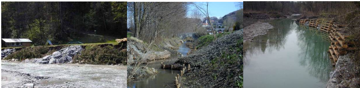
Abbildung Links: Buhnen und Totholzbäume; Mitte: Ingenieurbioologische Verbauungen; Rechts: mit Erdreich verfüllte Holzkästen
