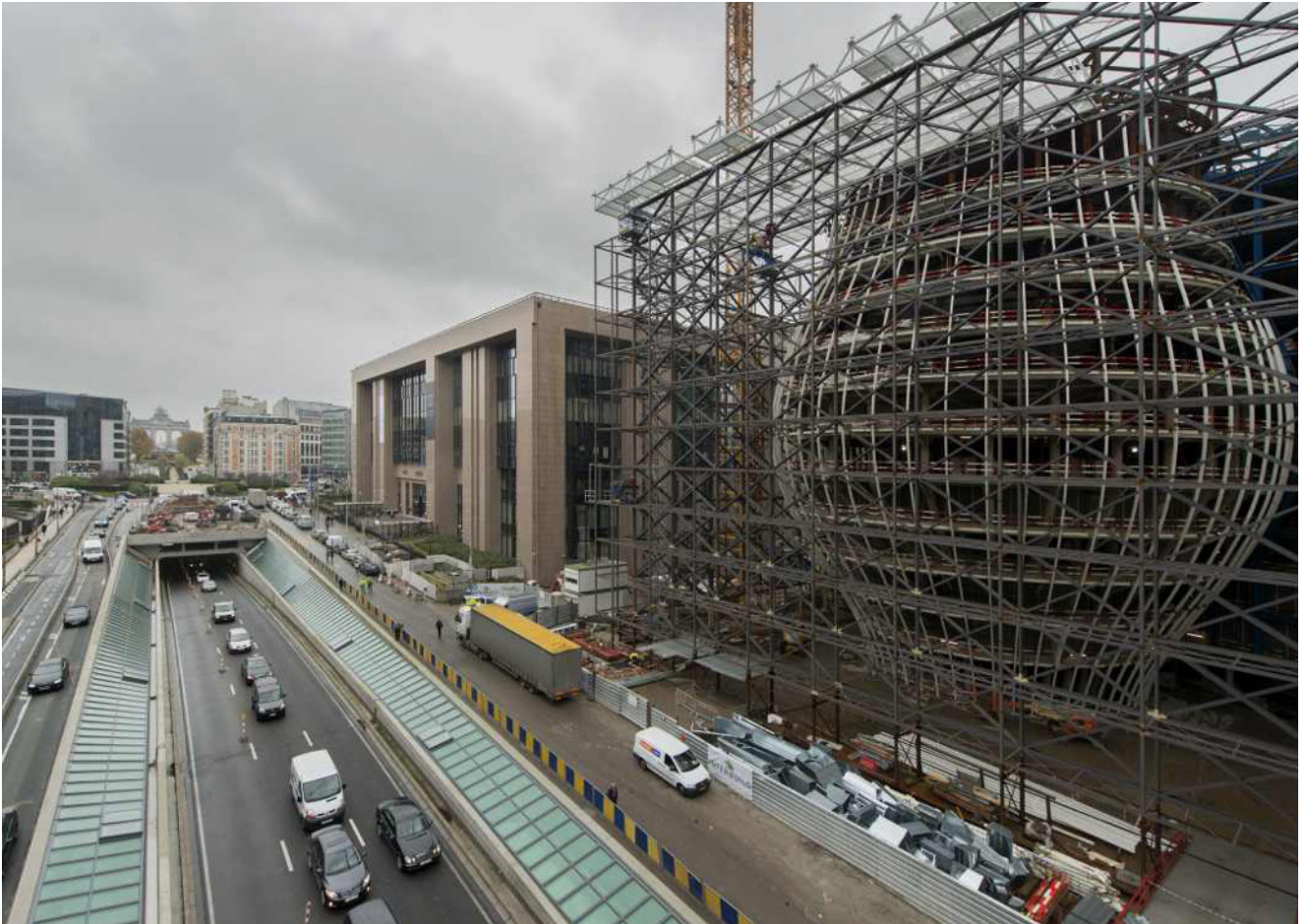
Bau der „Lanterne“ und des Europa-Gebäudes, Rue de la Loi, Brüssel.
