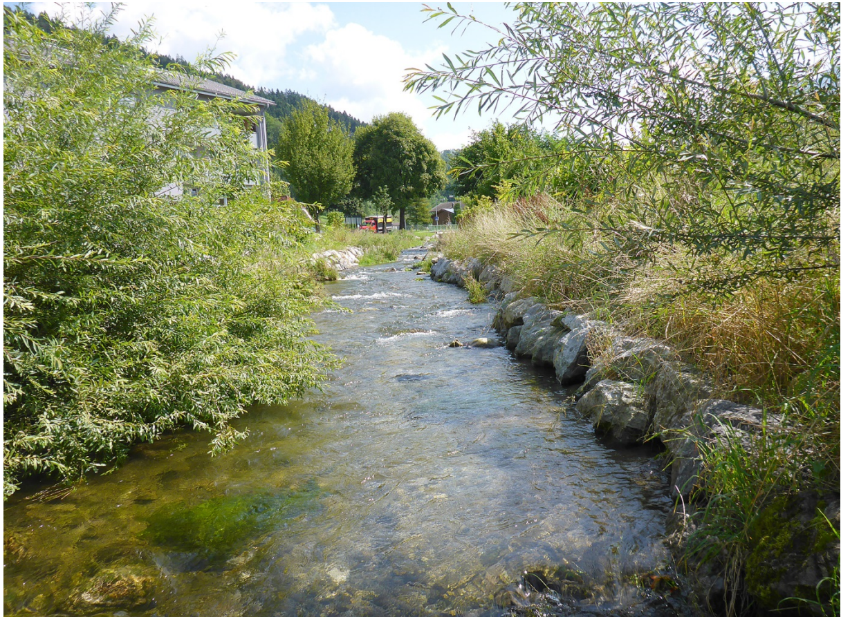
Abb.: Renaturierter Gewässerabschnitt des Schwarzbachs
