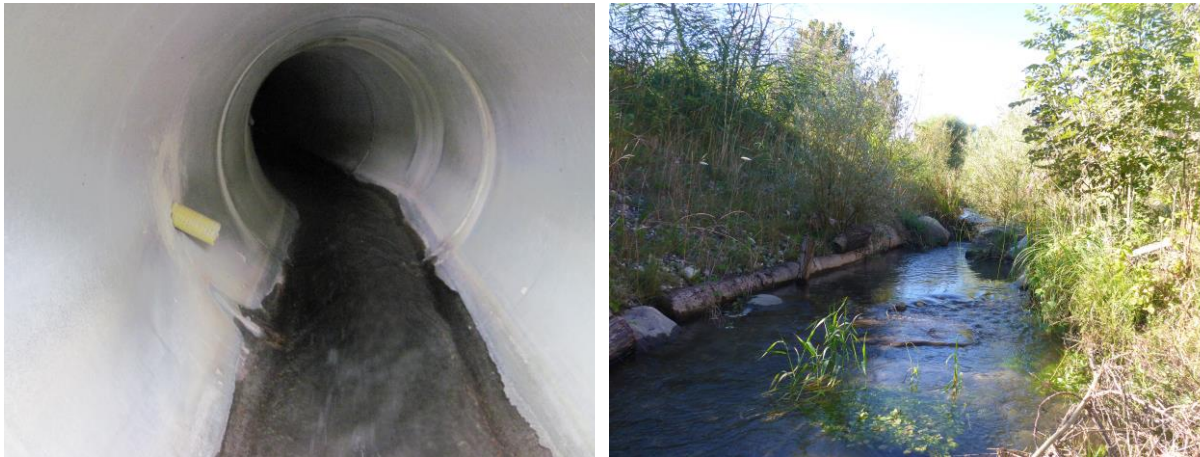
Foto 2 und 3: Links: bestehende Gewässerverrohrung im Bützengraben; Rechts: revitalisierter Gewässerabschnitt im Bützengraben, © Umweltinstitut
