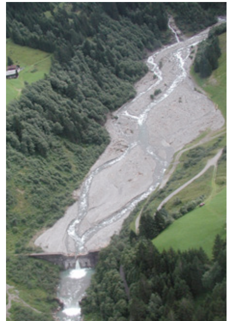
Geschiebesperre in der Litz (Bild der WLV)
