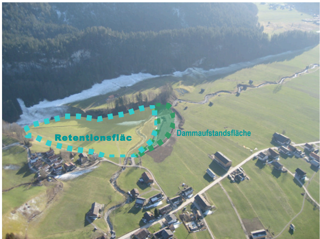
Retentionsbecken am Grebenbach in Bezau
