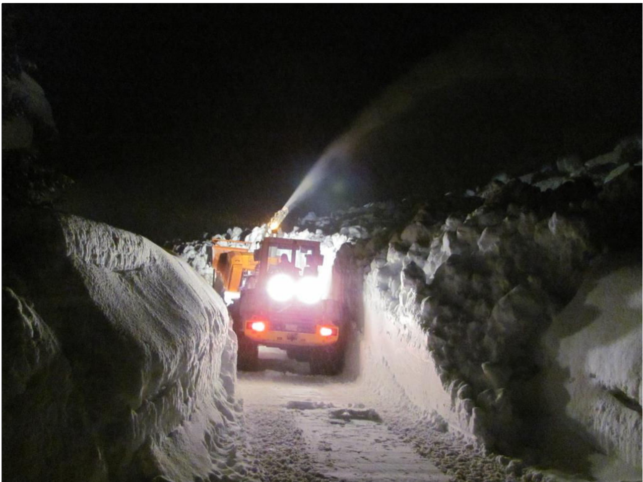
23. Jänner 2012: Räumung im Ablagerungsbereich nach der erfolgten Sondierung und Sicherheitssuche
