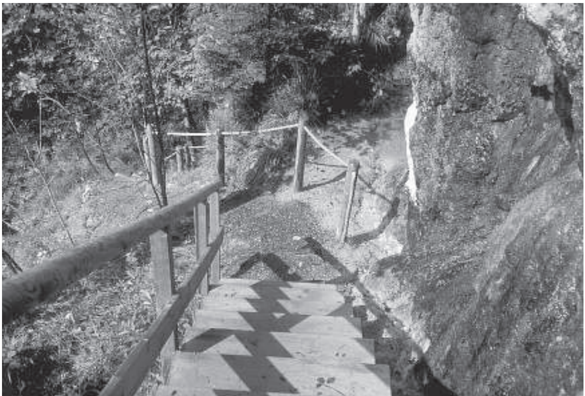
Neuanlage des Quelltuffweges in Lingenau.
