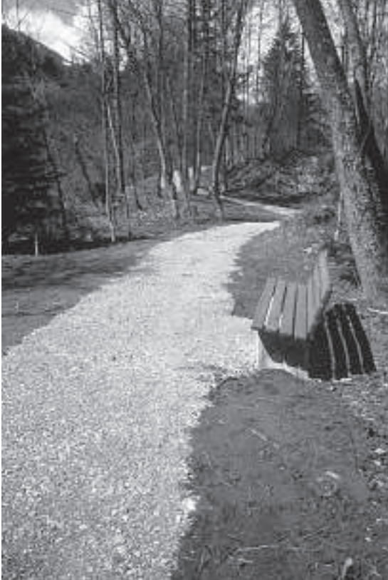
Neu gebauter Spazierweg an der Ill bei Schruns.
